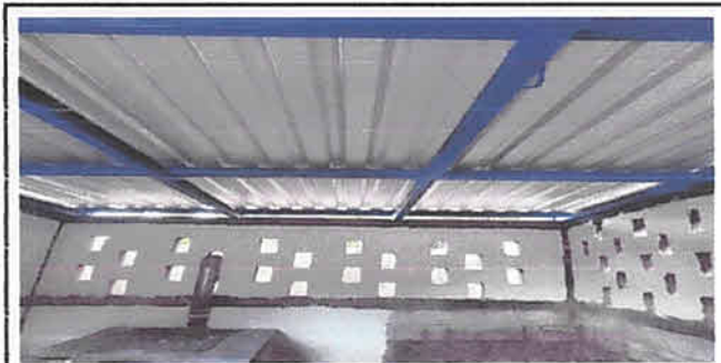
Foto 6: sustitución de techo a cocina
