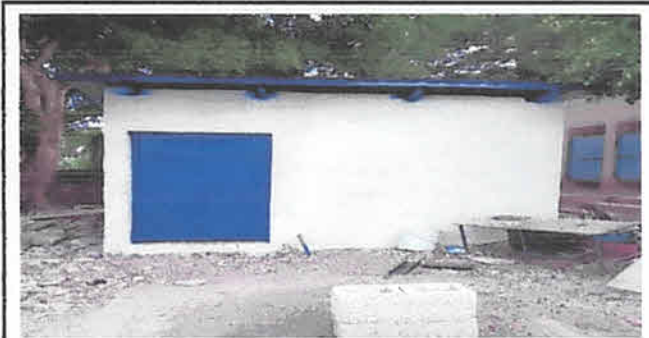
Foto 4: sustitución de puerta de metal para cocina
