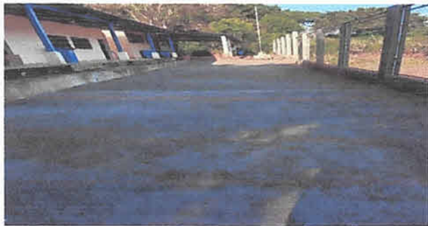
Foto 1: reparación de losa de piso
