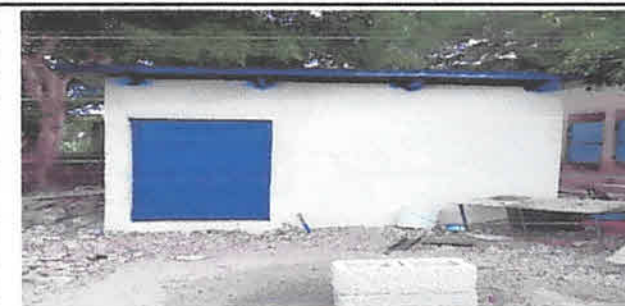
Foto 5: repello y cernido de muro de cocina
