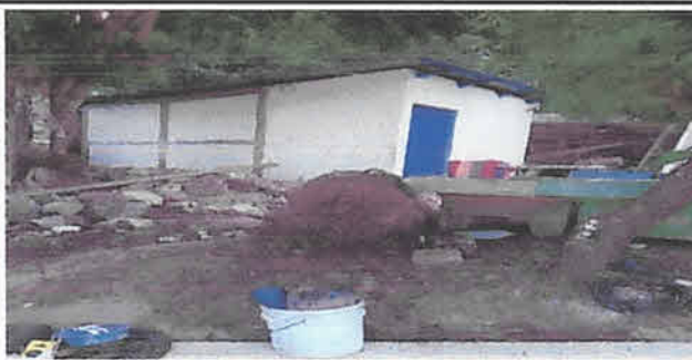
Foto 3: remozamiento de muro de block de cocina,
