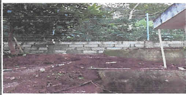
Foto 2: reparación de muro perimetral
